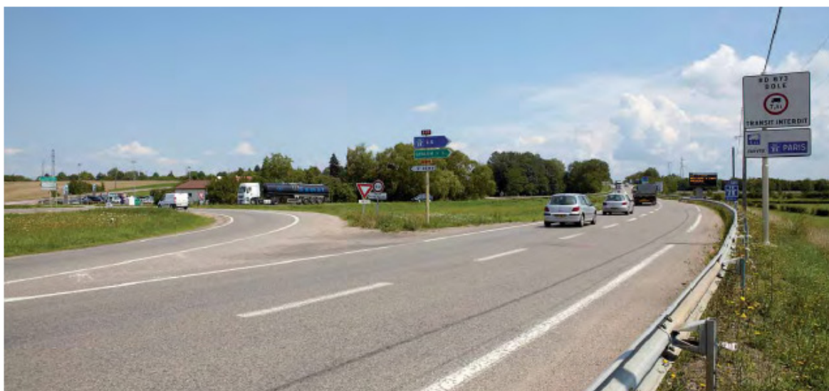
LE GRAND CHALON participe au financement des travaux d'aménagement des échangeurs de Droux-Cortelin
